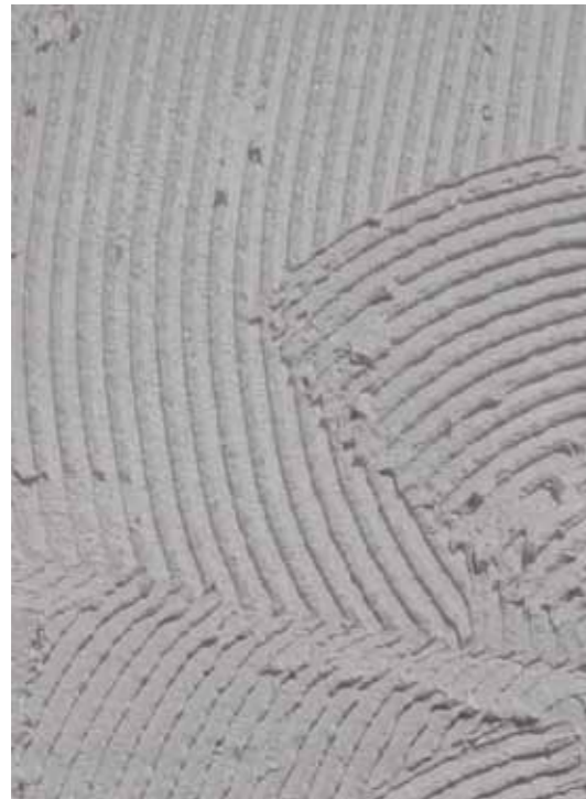
Application d'une couche de JEF COTHERM SC
