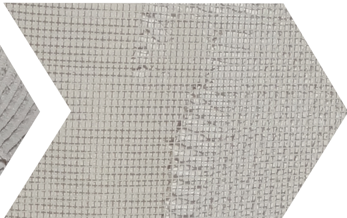
Pose de l'armature
