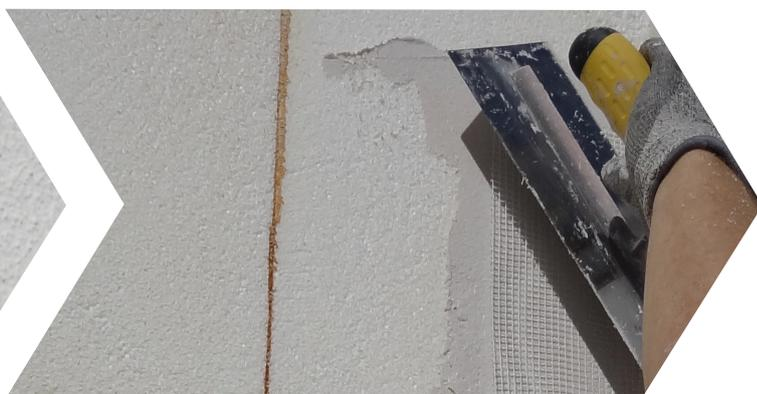
**Mise en place des profilés d'angle** : Il est conseillé d'utiliser des profilés d'angle en aluminium ou en PVC pré-entoilés. La pose des profilés d'angle se fait avec JEFOTHERM POUDRE. Ne pas poser les profilés bord à bord mais respecter un espace de 2 à 3 mm pour laisser les profilés se dilater si nécessaire.
