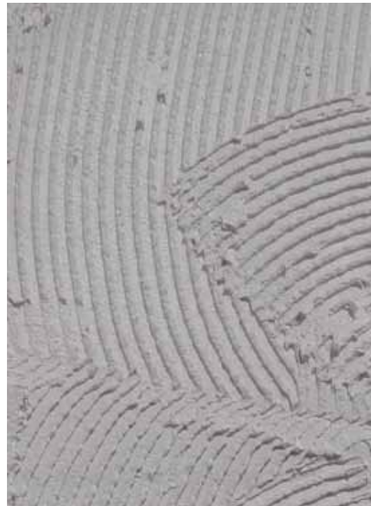
Application d'une couche de JEF COTHERM COLLE
