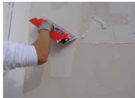
Pose de l'armature
