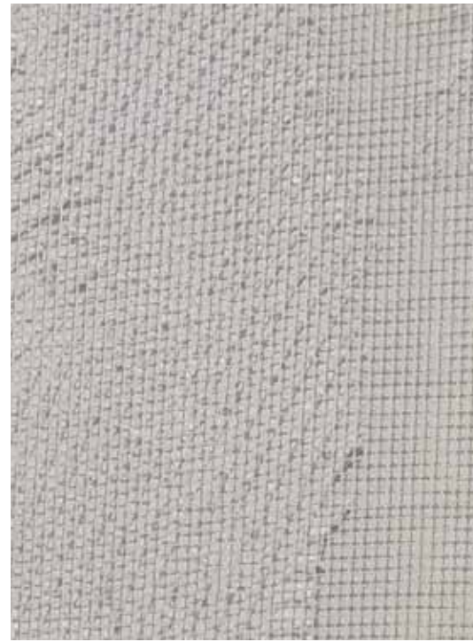
Pose de l'armature
