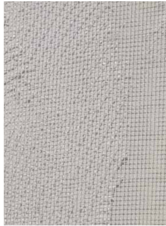
Pose de l'armature
