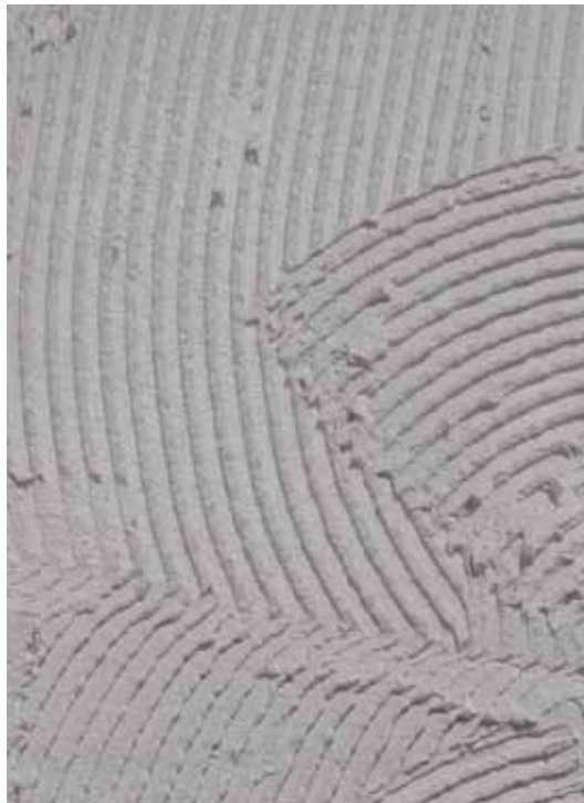
Application d'une couche de JEFOTHERM SC
