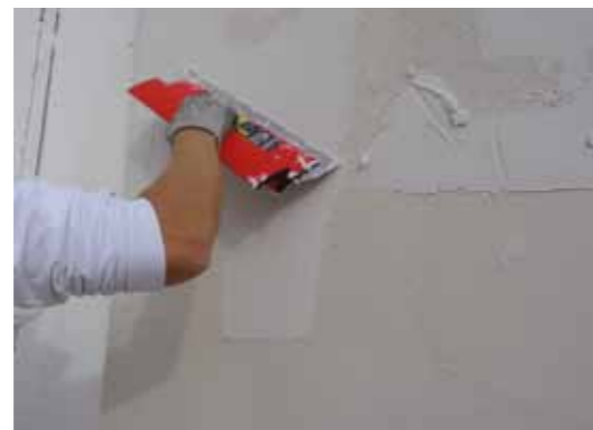
Pose de l'armature
